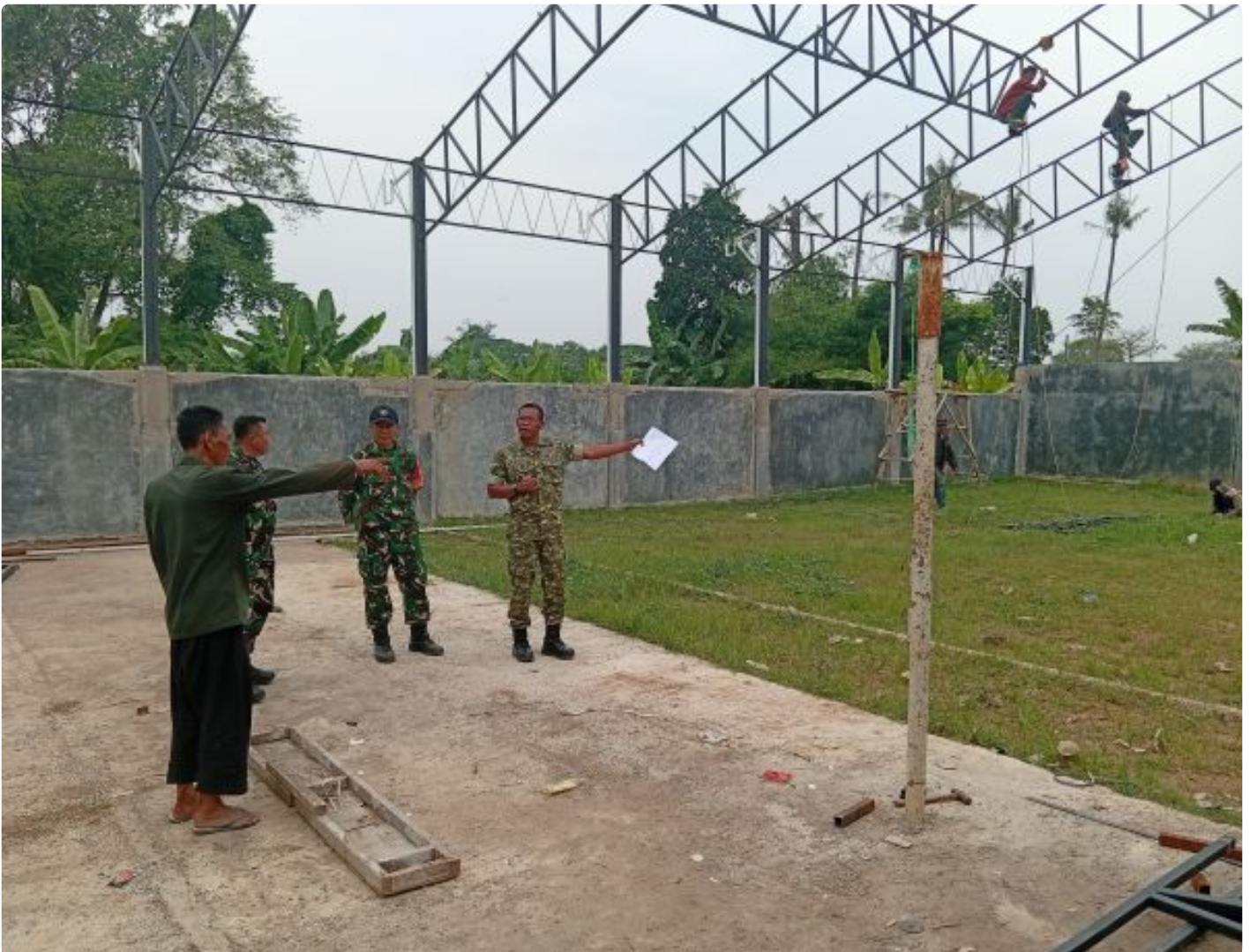
Progres pemasangan kuda-kuda BRC
